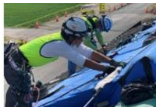
屋根の上での作業。9月現在も続いています。
